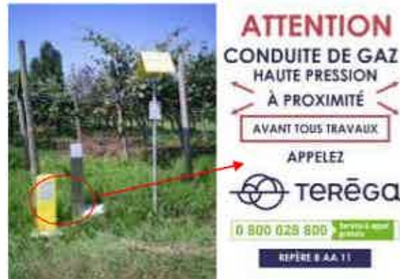
Figure 29 : Bornes de repérage du tracé et plaque signalétique associée
