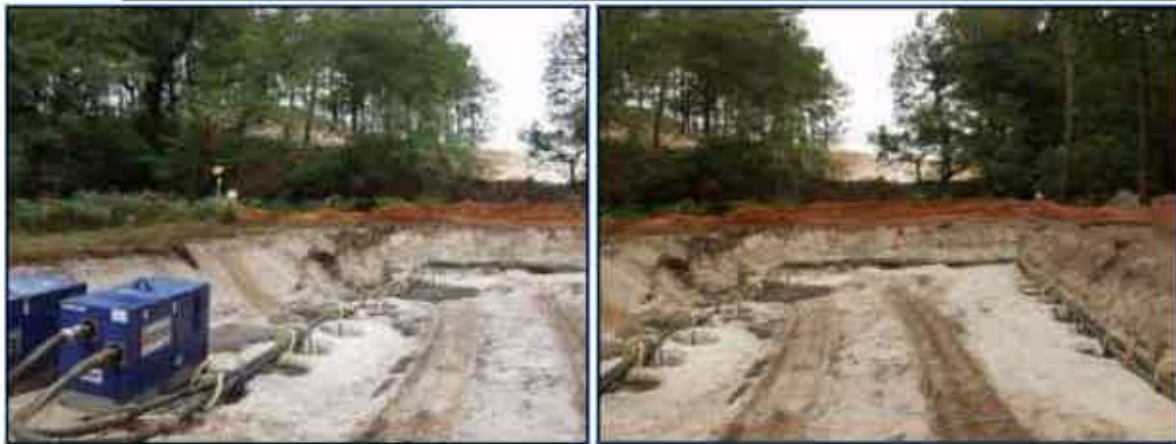
Figure 47 : Pompes et aiguilles filtrant
