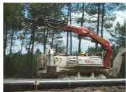
Déchargement des tubes du porte tubes
