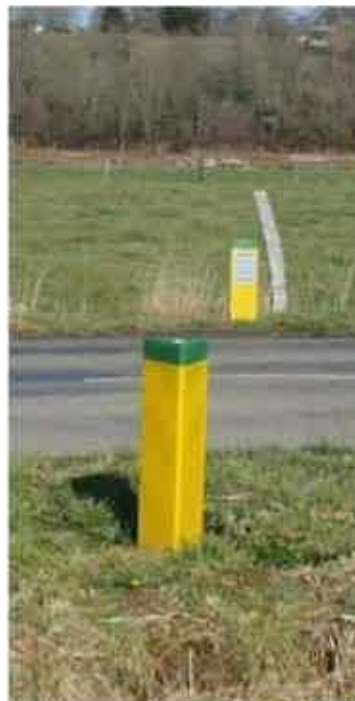
Figure 30 : Bornes utilisées pour une canalisation en arrêt d'exploitation définitif
