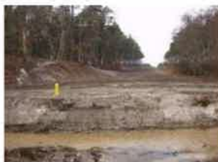
Situation en phase chantier.
