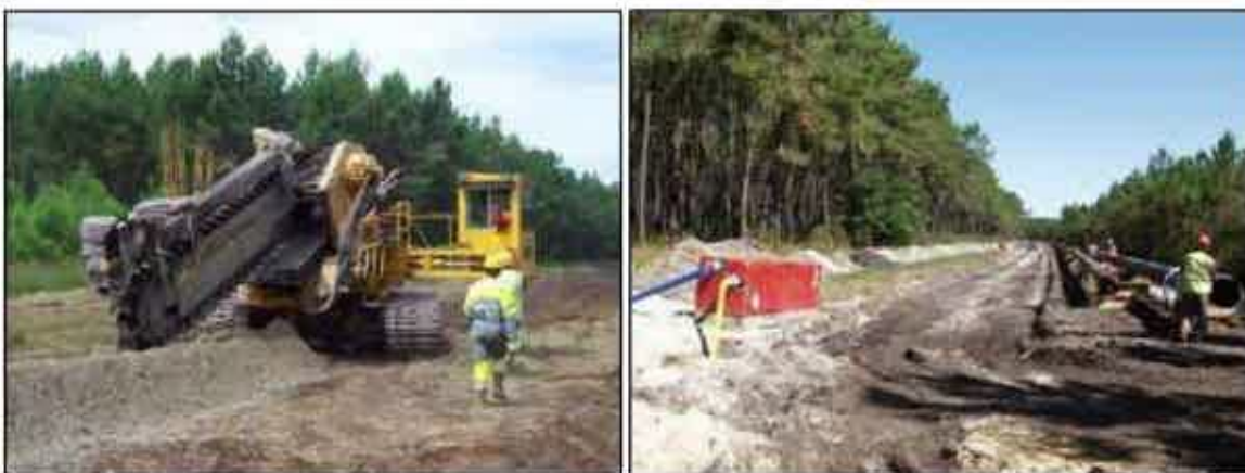
Figure 46 : Travaux de pose de la tranchée drainante et groupes de pompage
