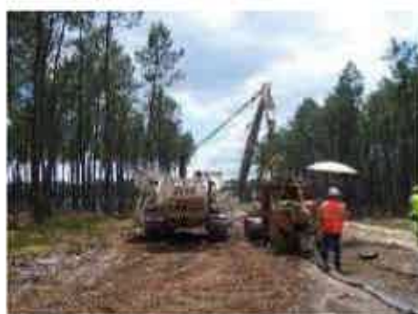
Cintrage des tubes
