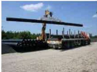
Chargement des tubes
