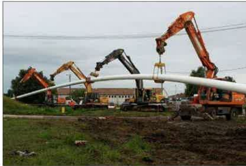
Figure 41 : Exemple d'une mise sur caténaire
