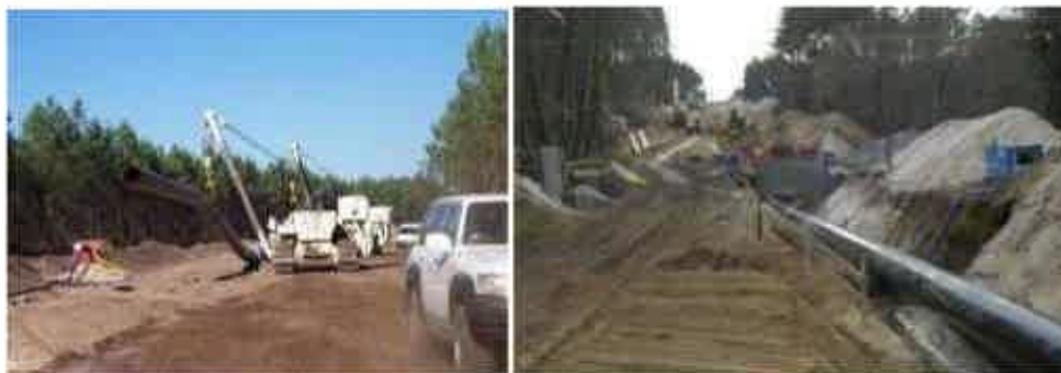
Figure 26 : Mise en fouille
