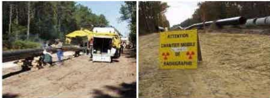
Soudage des tubes
