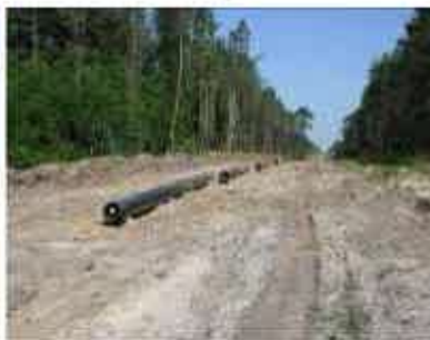
Bardage des tubes sur la piste
